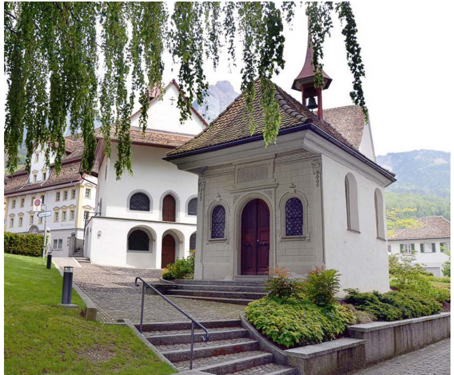
Kerchel mit Michaelskapelle im Hintergrund sowie Heiligkreuzkapelle im Vordergrund. Foto: Bernhard Reichmuth
