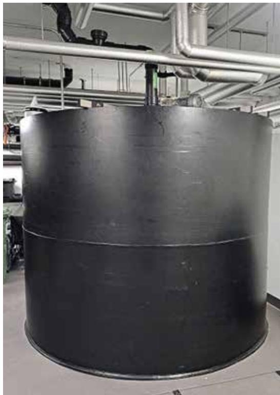
← Durch eine Leitung gelangt dieser Brei nun in einen Tank, der mehrere tausend Liter fasst. Hier lagert der Brei maximal sechs Monate lang und wird mittels des eingebauten Rührwerks in Bewegung gebracht. Dadurch setzt eine gewollte Gärung ein. Ist der Tank beinahe voll, meldet sich dieser automatisch bei der Häckseleinheit und ein Lastwagen wird zur Absaugung aufgeboden.
