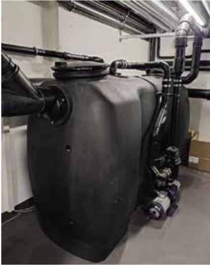
← Parallel dazu wird aus dem Abwasser der Küche alles Fett extrahiert. Dieses wird in einem leicht geheizten Tank gesammelt und bei einem hohen Füllstand ebenfalls abgesaugt.
