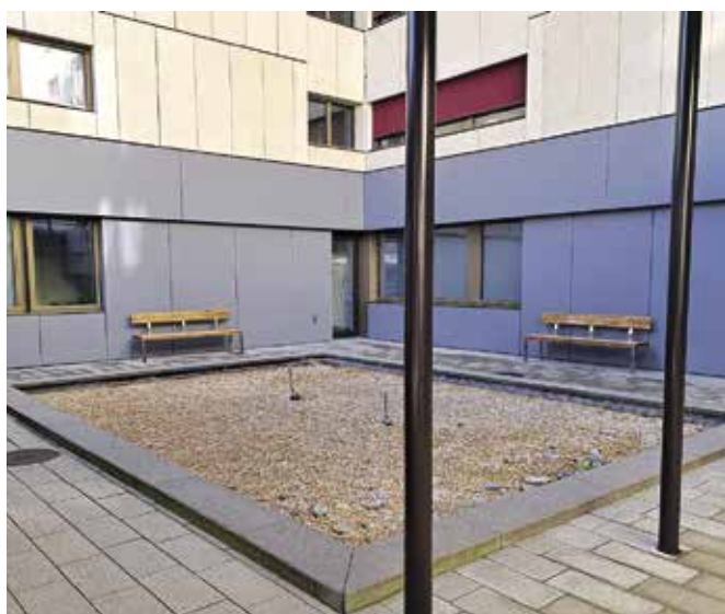
15. März 2023: Beginn der Abrissarbeiten des alten Beckens.
