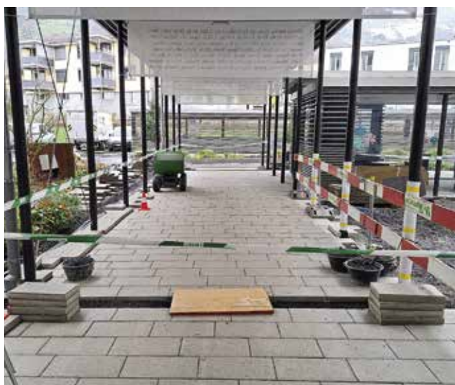
29. März 2023: Einbau der Bewässerung und Energiezuleitungen.
