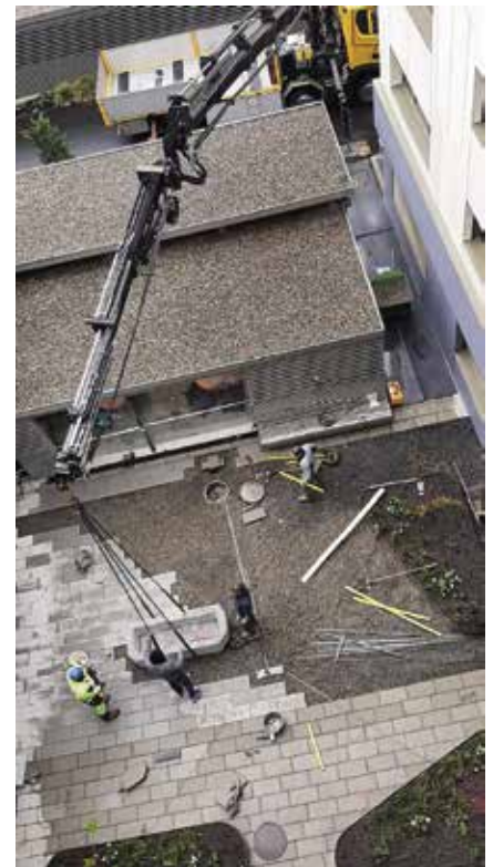
Rechts: 14. April 2023: Der Brunnentrog wird «eingeflogen» und die Plattenbeläge werden fertiggestellt.
