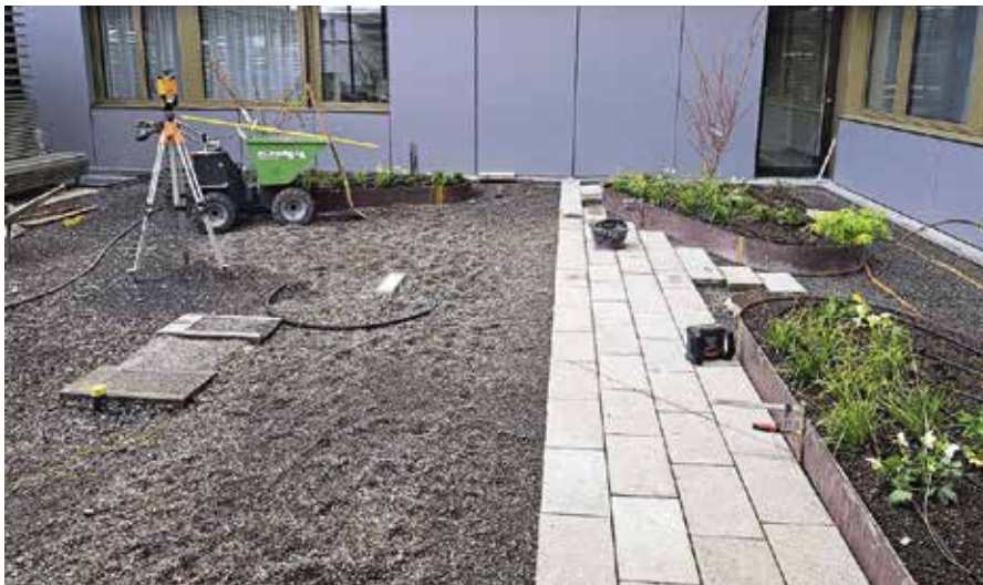
Oben: 11. April 2023: Beginn der Plattenarbeiten nach Ostern.
