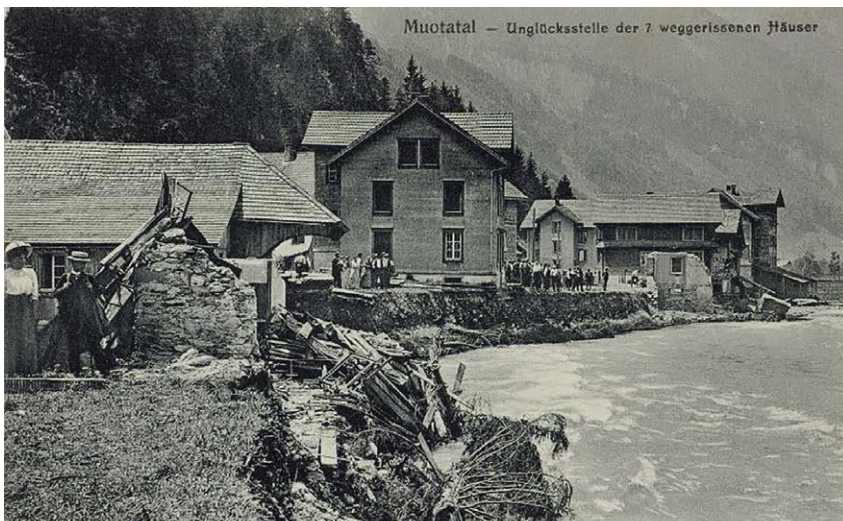
«Muotatal – Unglücksstelle der 7 weggerissenen Häuser.»
